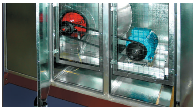
Передача защищена сеткой
