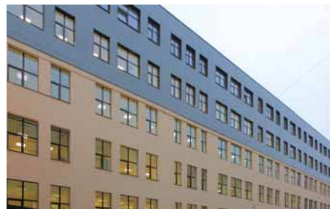
Административно-офисное здание «Тайм-центр», г. Москва
