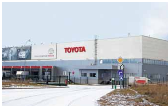
Офисно-производственный комплекс компании TOYOTA, Московская область, 84-й км. МКАД
