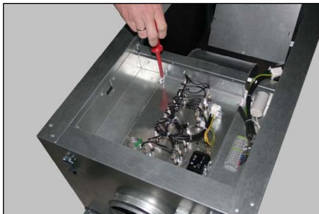
4. Зафиксируйте нагреватель с помощью саморезов
