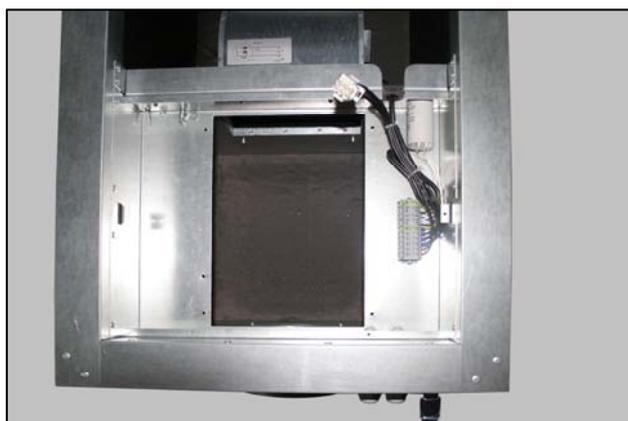
2. Вентиляторный блок CAUF – отсек для установки нагревателя
